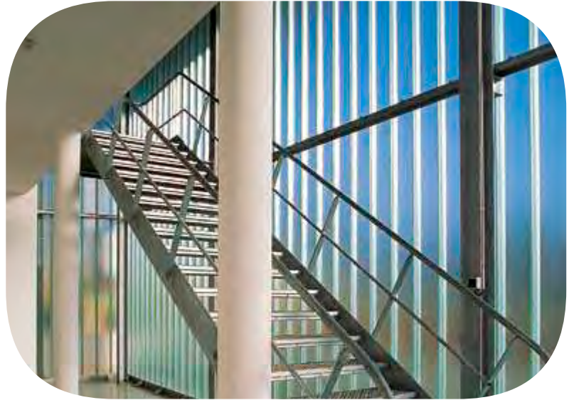
EDF sähköasema, Neuilly-sur-Marne, Ranska. Pilkington Profilit ™
